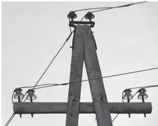
Изолятор с удлинненным путем по поверхности (это и два следующих фото сделаны А.Кузнецовой)
